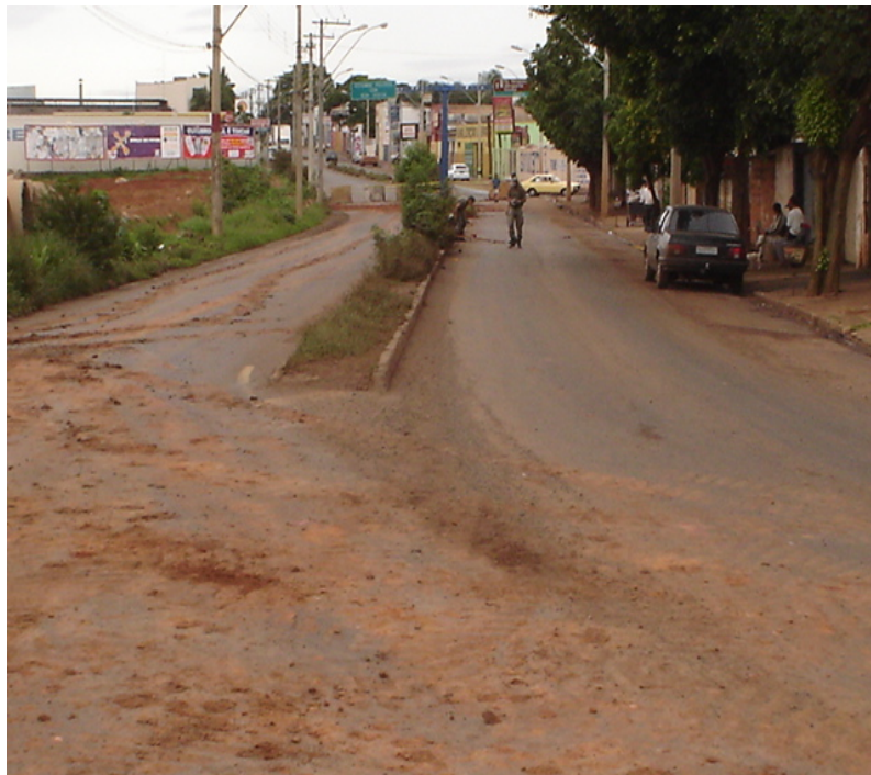
Figura 6 - RUA A SER ESCAVADA
