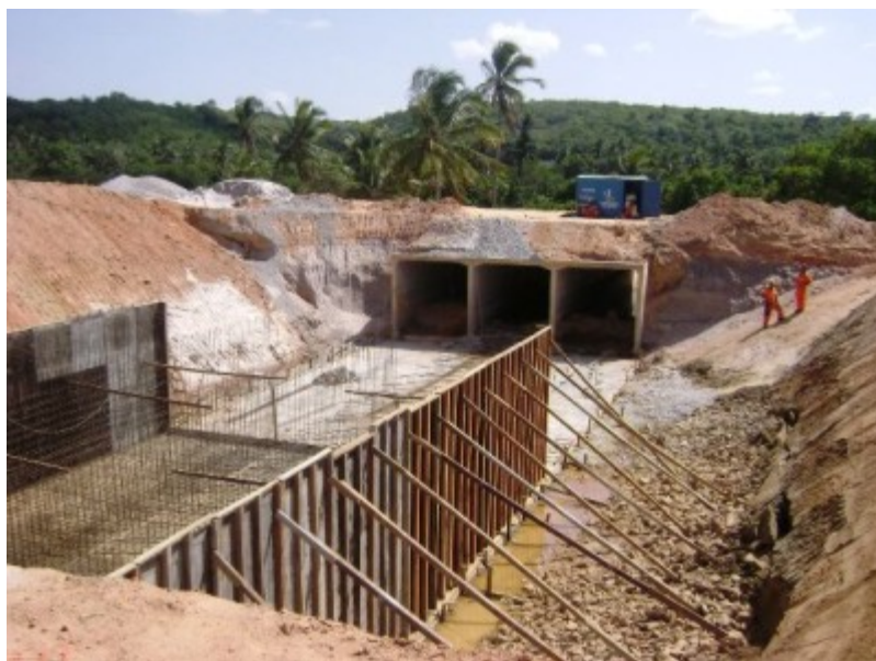
Figura 16 - CONSTRUÇÃO DA ARMAÇÃO
