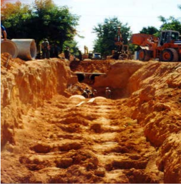
Figura 5 - REATERRO DE VALA / CAVA
