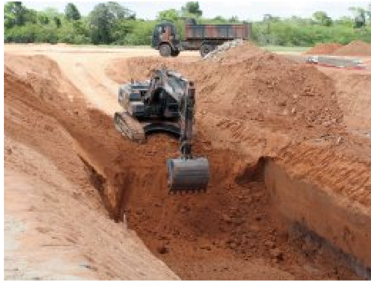
Figura 14 - ESCAVAÇÃO DE VALA / CAVA PARA BTCC
