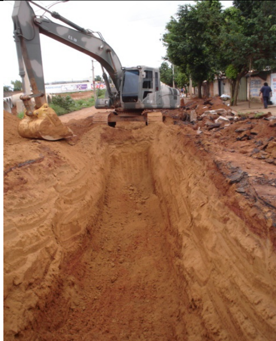
Figura 7 - ESCAVAÇÃO DE VALA / CAVA PARA BSTC
