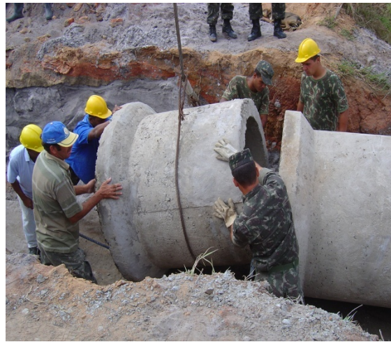
Figura 8 - CONFEÇÃO DE BERÇO DE CONCRETO E ASSENTAMENTO DE BSTC
