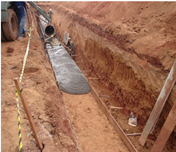
Figura 8 - CONFEÇÃO DE BERÇO DE CONCRETO E ASSENTAMENTO DE BSTC
