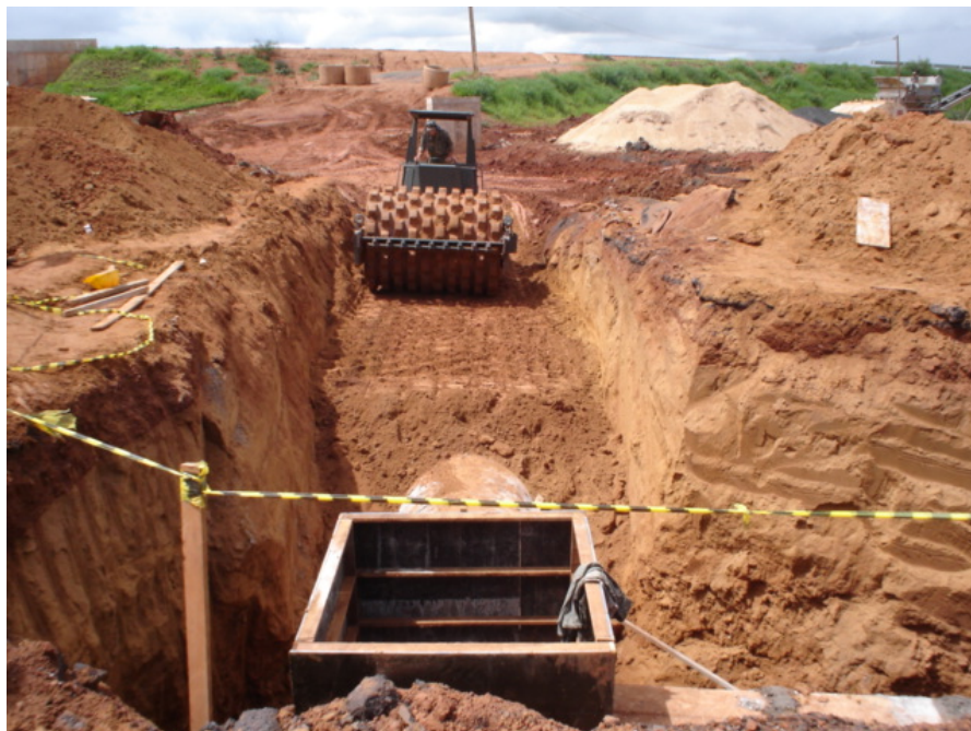
Figura 11 - COMPACTAÇÃO DE REATERRO
