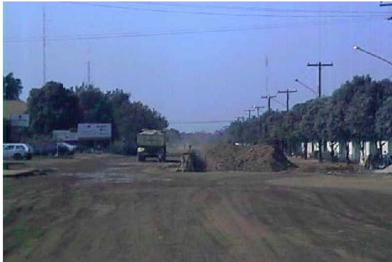
Figura 1 - ESCAVAÇÃO DE VALA / CAVA
