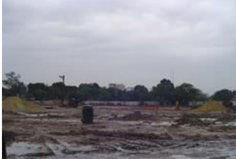
Foto 03 - Identificação de um local úmido onde será necessário a construção de colchão drenante.
