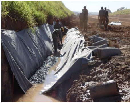
Foto 01 - Lç da manta geotextil e da brita
