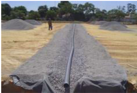
Foto 05 - Lç do tubo PVC para o colchão drenante.
