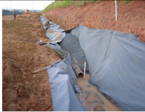
Foto 02 - Lç do tubo de concreto.
