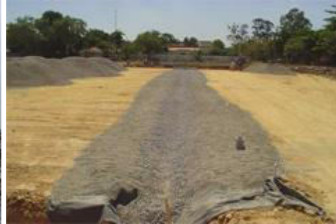
Foto 04 - Delimitação do local com brita e manta geotextil para utilização de tubo de PVC para o colchão drenante.
