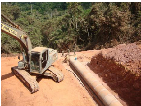
Corpo do bueiro concluído com concretagem das manilhas e do contra berço
