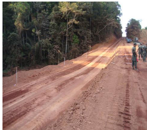
Desvio concluído e sinalizado.
