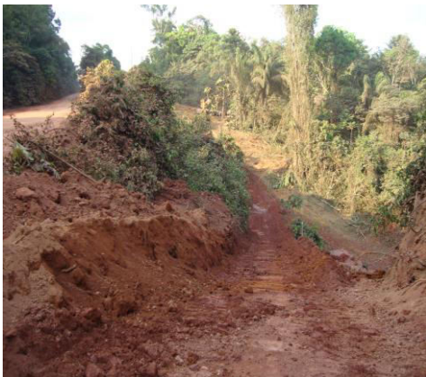
Abertura e reforço do desvio e retirada da camada vegetal
