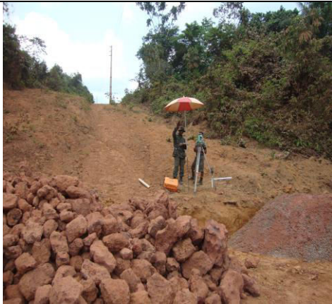
Equipe de topografia faz a locação do bueiro
