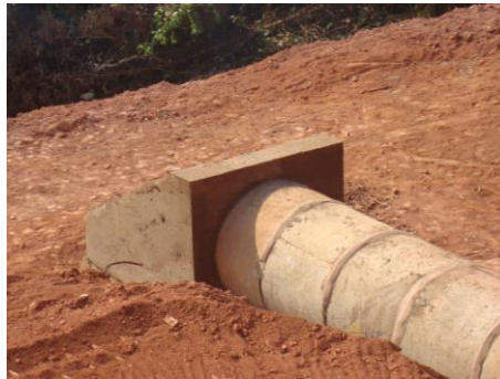
Boca do bueiro concretada
