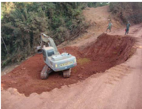
Início da escavação da rodovia
