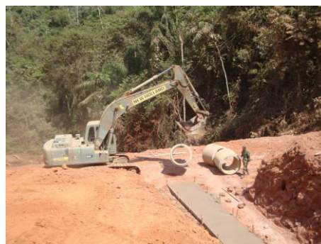
Posicionamento das manilhas do bueiro
