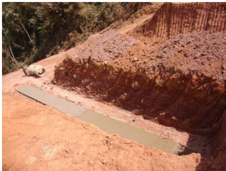
Berço do bueiro concretado
