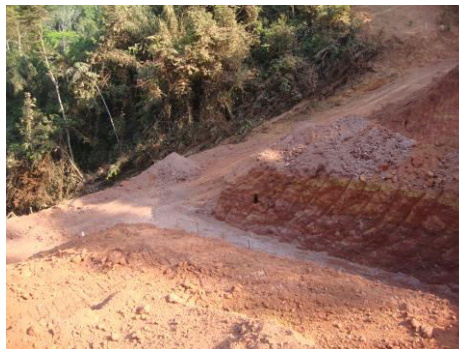
Escavação da vala em forma de degrau para diminuir a instabilidade do corpo do aterro.
