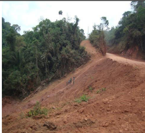
Marcação dos off-sets e das cotas de jusante e montante com sua esconsidade.
