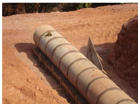
Montagem da caixaria da ala do bueiro
