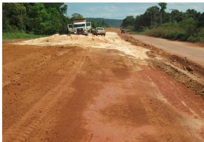
Figura 2 – Execução de base (solo laterítico com mistura de areia).
