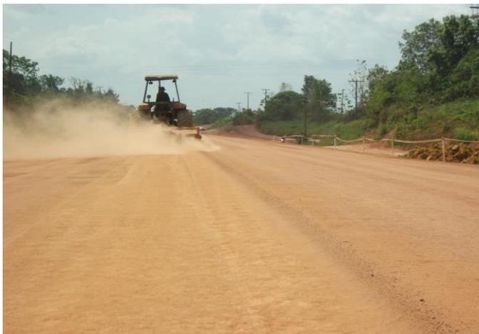
Figura 1 – Limpeza antes da execução da base.
