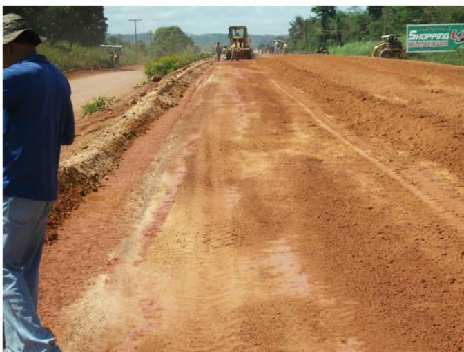
Figura 3 – Homogeneização do material de base.
