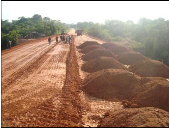
Descarga de material (Foto 01)
