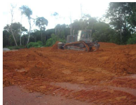
Cobertura Vegetal / Hidrosseadura
