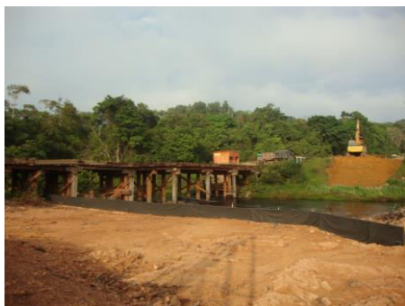
Dispositivo de contenção provisório / APP
