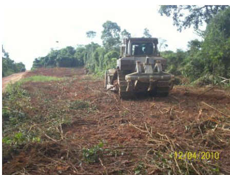
Supressão vegetal na faixa de domínio
