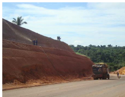
PRAD - Reconformação de talude
