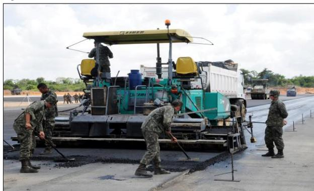
2) Para a correta distribuição da massa asfáltica é necessário que: o suporte esticador esteja na posição correta; o cabo guia esteja sem emendas (nós), preso no suporte e totalmente esticado e o sensor eletrônico tenha livre passagem pelo suporte esticador.
