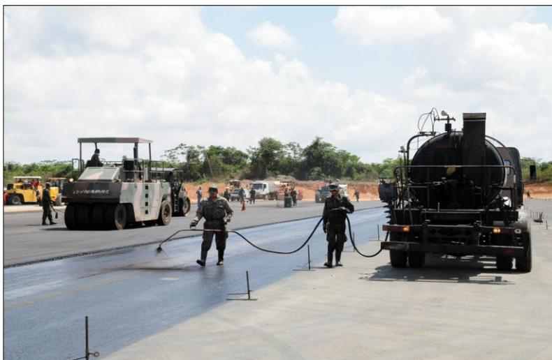
Observação: Essas falhas, decorrentes do entupimento dos bicos dos espargidores, deverão ser corrigidas antes da próxima aplicação.
