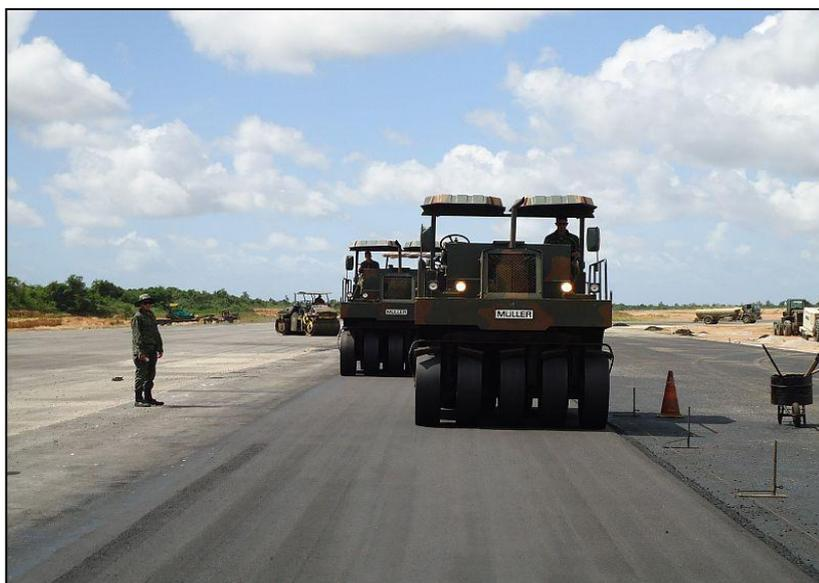
3) Após o emprego dos KP (executarem o número de passadas previstas pela Equipe Técnica), o Rolo Liso (KL) é empregado para realizar o acabamento final do pavimento, inclusive as juntas longitudinais.
