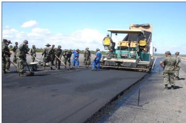
2) O Acabamento da junta longitudinal entre as faixas de material asfáltico lançado, não deve permitir a formação de saliências entre as mesmas.
