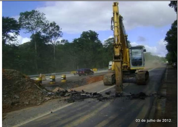
**DEMOLIÇÃO E REMOÇÃO DE PLACAS DE CONCRETO PARA ESCAVAÇÃO DA PASSAGEM DE FAUNA DA MATINHA DE GOIANA**
