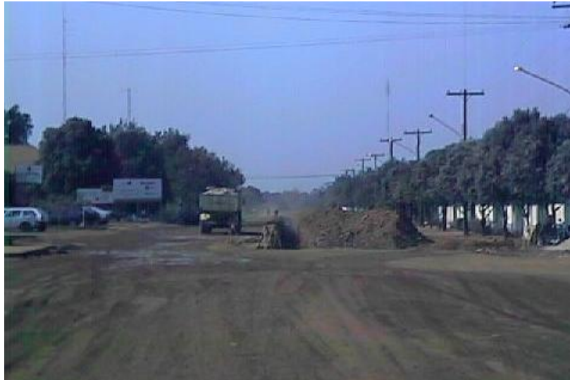
Figura 1 - ESCAVAÇÃO DE VALA / CAVA
