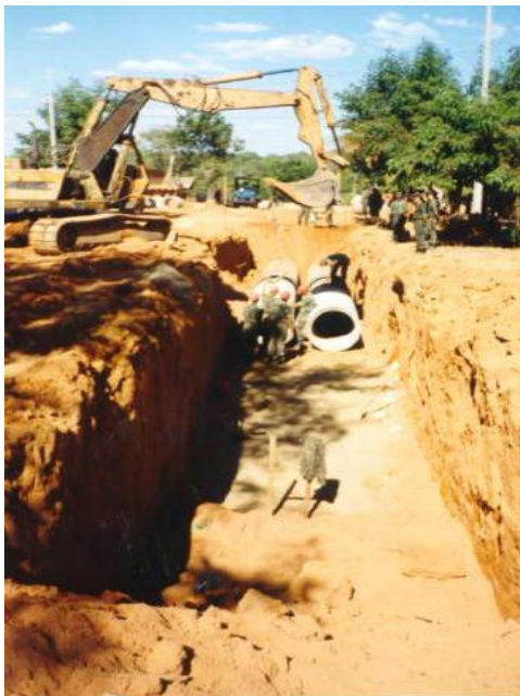
Figuras 3 e 4 - ASSENTAMENTO DE BDTC
