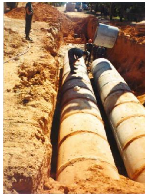
Figuras 3 e 4 - ASSENTAMENTO DE BDTC
