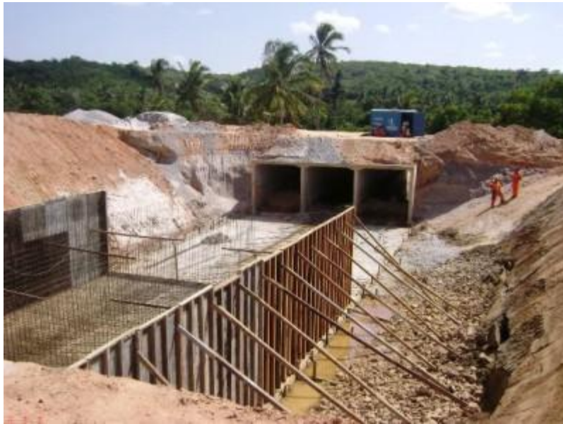
Figura 16 - CONSTRUÇÃO DA ARMAÇÃO
