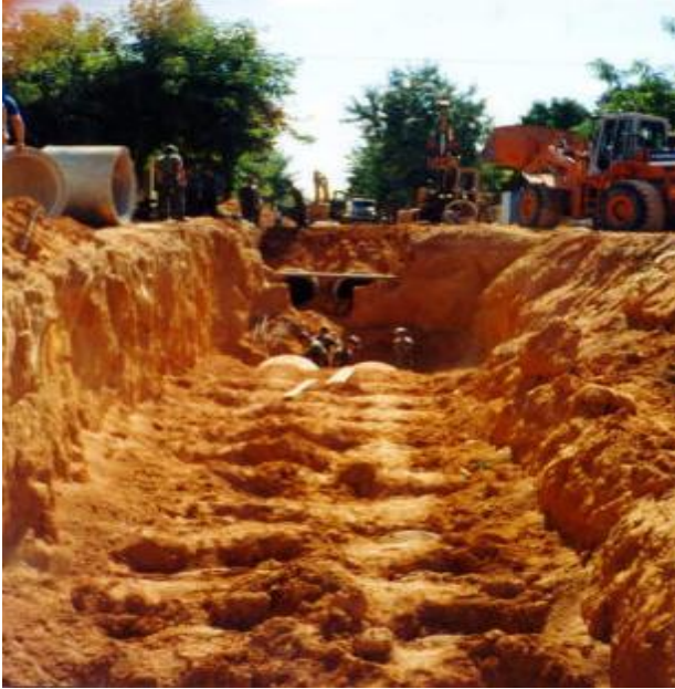
Figura 5 - REATERRO DE VALA / CAVA
