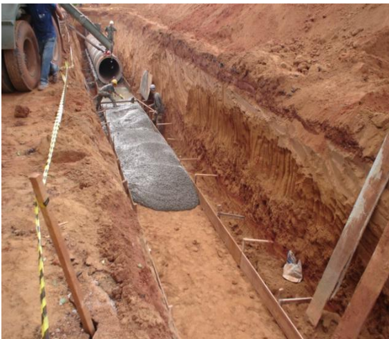
Figura 8 - CONFECÇÃO DE BERÇO DE CONCRETO E ASSENTAMENTO DE BSTC
