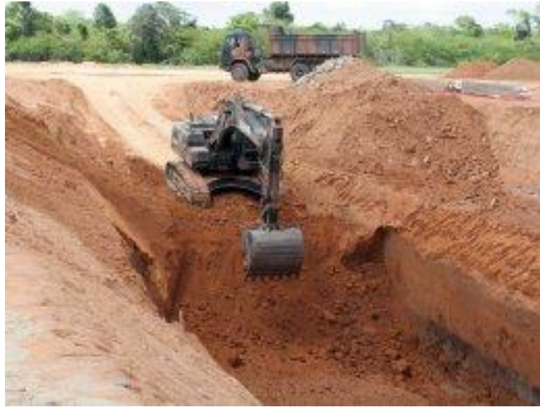
Figura 14 - ESCAVAÇÃO DE VALA / CAVA PARA BTCC
