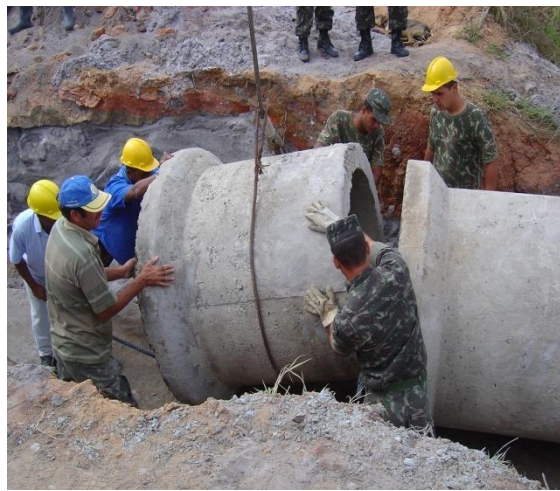
Figura 8 - CONFECÇÃO DE BERÇO DE CONCRETO E ASSENTAMENTO DE BSTC
