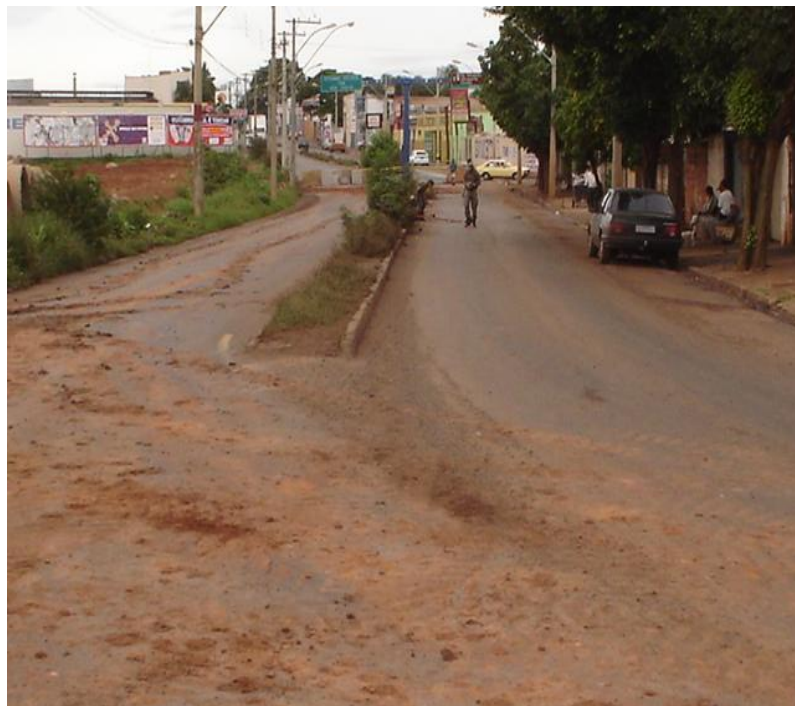
Figura 6 - RUA A SER ESCAVADA
