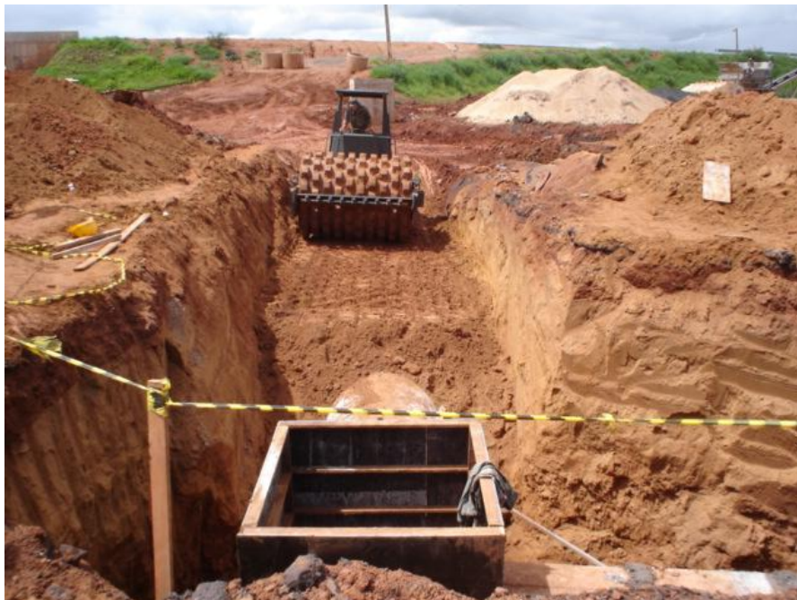
Figura 11 – COMPACTAÇÃO DE REATERRO
