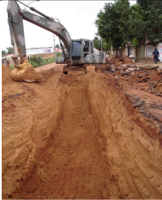
Figura 7 - ESCAVAÇÃO DE VALA / CAVA PARA BSTC
