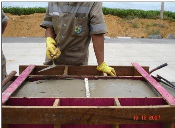
Após a retirada da forma, deverá ser realizado o acabamento. Verifica-se o alinhamento entre as juntas da barreira e do pavimento.
