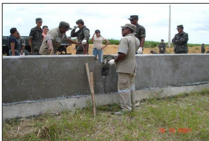
Depois de aberta barreira, deverá ser confeccionada uma forma para contenção do concreto e introduzida a folha de isopor.
