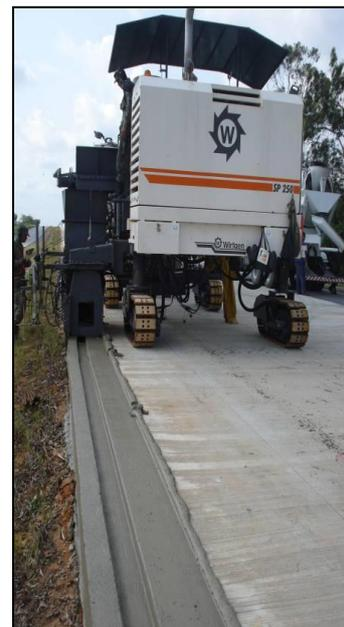
Quando tratar-se de pavimento asfáltico, será necessário realizar o corte do asfalto com a máquina de corte para piso auto propelida, a preparação do local para o recebimento do concreto da base da barreira com o emprego da retroescavadeira
