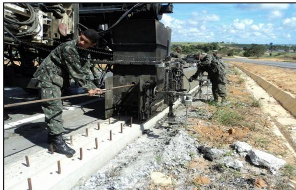
As barras de aço CA 50 são amarradas em sua extremidade, conforme previsto nas normas técnicas (transpasse de 8 cm).
